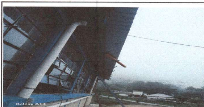
FOTO 6: Sustitución de soporte o pescante metal para canal
