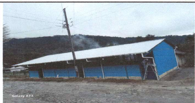
Foto 7: Pintura en muros exteriores e interiores
