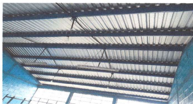
FOTO 3: Mantenimiento a estructura de soporte de metal
