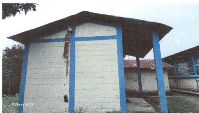
Foto 9: Sustitución de chimenea de metal
