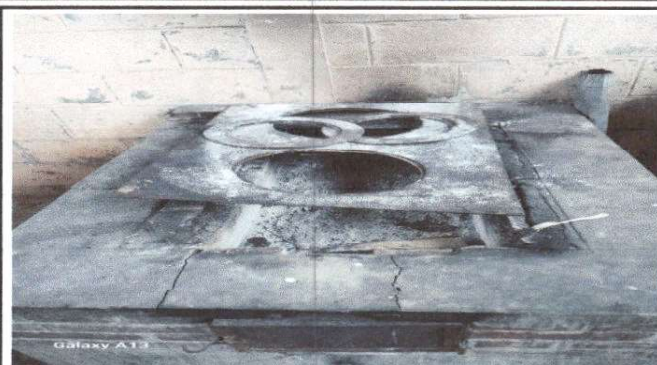
Foto 8: Sustitución de plancha de metal de 3 hornillas
