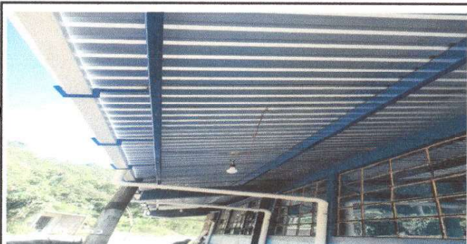
FOTO 5: Sustitución de canal de metal por canal de PVC
